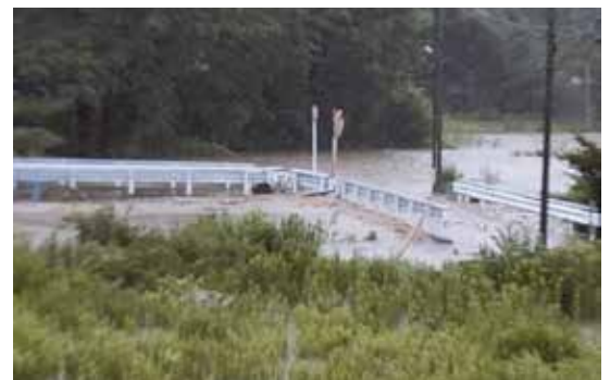
・現在の高橋と低橋 R5. 7/15 午後の氾濫状況
