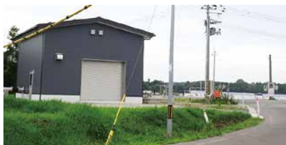
完成した小泉湧揚水機棟
