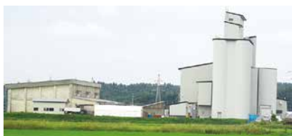
JA秋田なまはげ農業倉庫(左)と市北部地区カントリーエレベーター(右)
