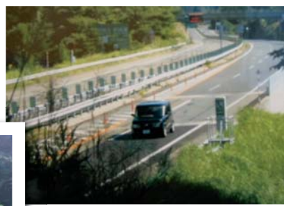
〈地区西部横断の自動車道〉
